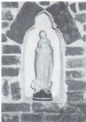
Afb. 1. Kaarsnis aan de binnenzijde van de voorgevel met geprofileerde dekstenen, tezamen een driepas vormend. (Foto: BAD)
