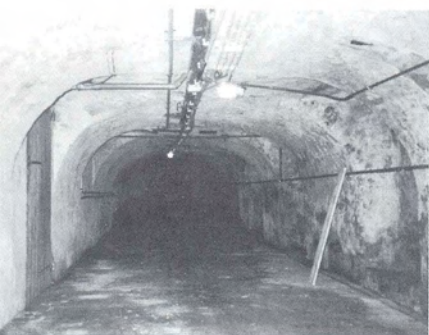
Afb. 2. Tongewelfde kelder onder de gang. (Foto: BAD)
